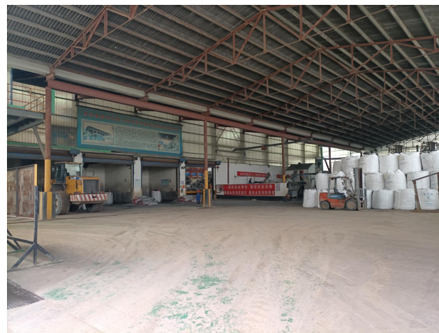
储存区地面硬化
